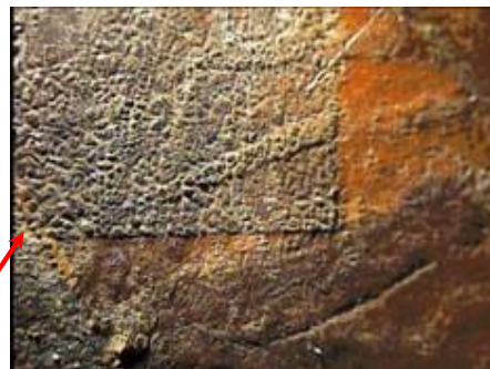
Φωτ.39: Το πάχος και η συρρίκνωση του επιφανειακού επιχρίσματος κατά τη διάρκεια του καθαρισμού.
