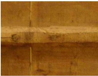
Εικ. 29: Λεπτομέρεια του τρέσσου στην οποία διαφαίνονται οι εφηλίδες των καρφιών και οι οπές των ξυλοφάγων εντόμων.
