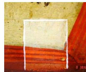
Εικ. 40: Δείγμα καθαρισμού κατά το οποίο αφαιρέθηκε το πρώτο στρώμα επιζωγράφισης από την περιμετρική ταινία
